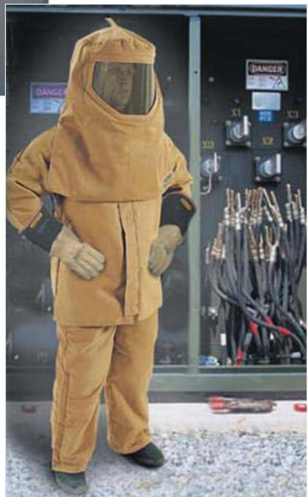
در شکل ذیل تجهیزات مورد استفاده برای جلوگیری از خرات ناشی از شوک و آرک فلش و نیز تجهیزات آلام دیده میشود :
