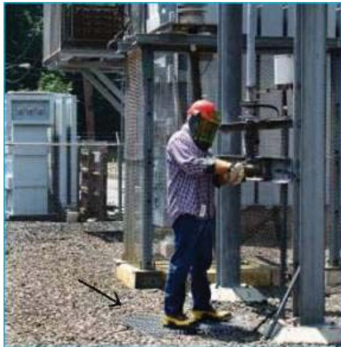
ب - افزایش مقاومت مناطق مستعد تماس با بدن (استفاده فرش عایق یا mat)
